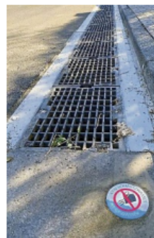
Die neuen Versickerungsrinnen sollen den Grundwasserschutz verbessern. PRIVAT
